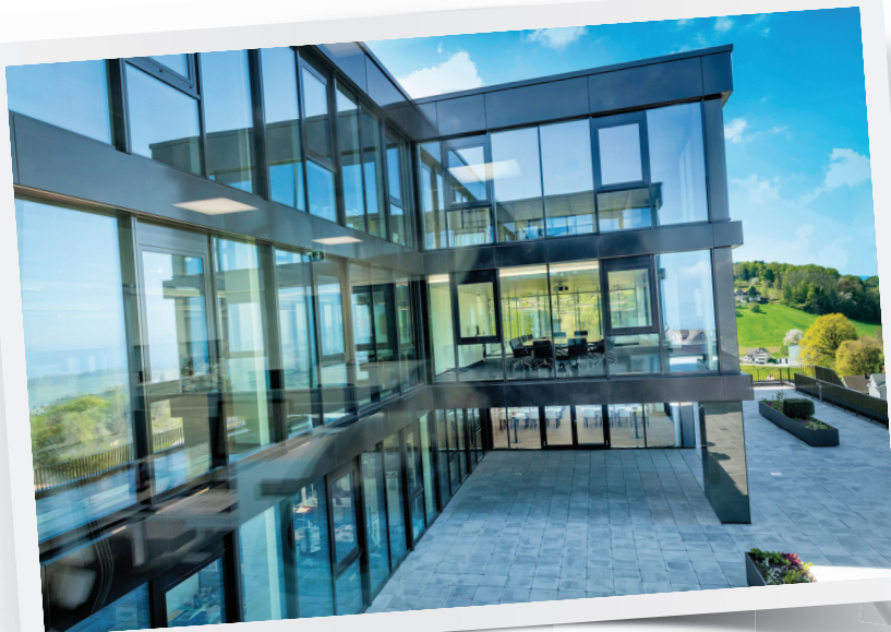
Planta elaboradora Just en Walzenhausen, Suiza.
